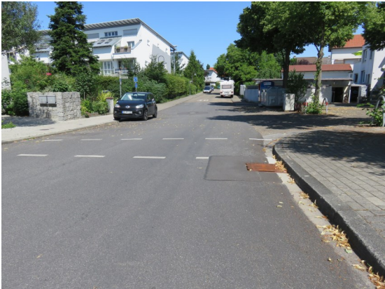
Am Stockfeld: Verkehrszeichen "Achtung Kinder" in Verbindung mit den Querungs- buchten für Fußgänger
